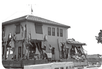
地震による住宅の損壊
